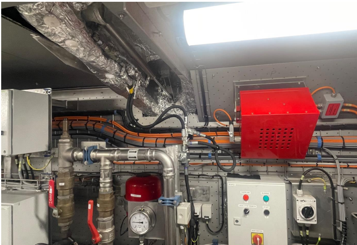
Figuur 28: Actuator brug op de ROE
