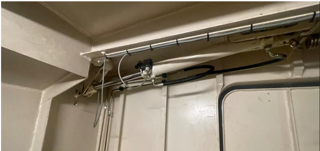
Figuur 31: Actuator brug RR – hydraulische cilinder
