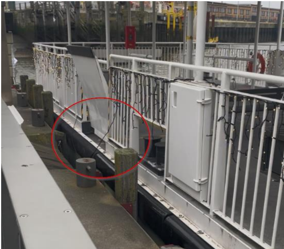
Figuur 29: Brug ROE
